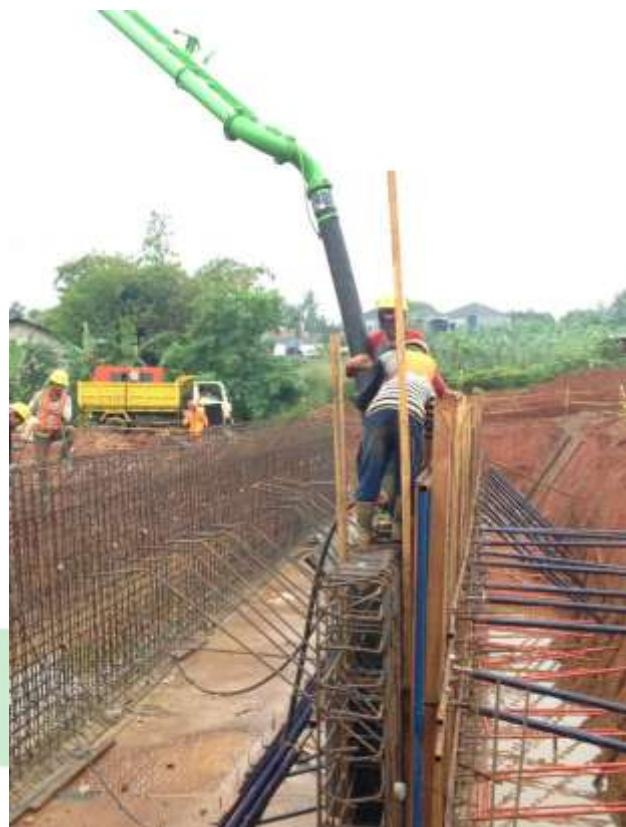
Gambar 5.1 Pekerja tidak menggunakan Body hardness
