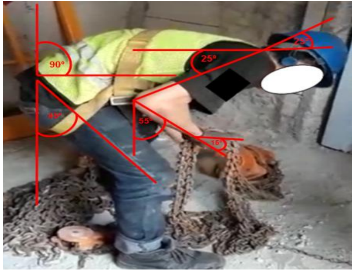
Gambar 4.3 Posisi aktivitas drop material/ manual material handling (merapihkan rantai chainblock yang terlilit dan akan diangkat ke dalam shaft lift )
