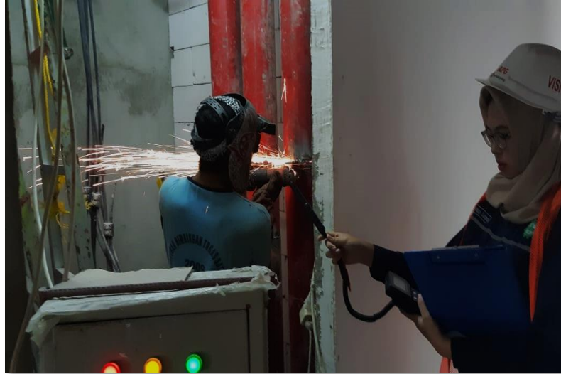
Pengukuran suhu panas dan kelembaban unit Riser Shaft
