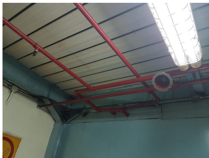
Gambar 4.7 Water spray sprinkler dan CO 2
