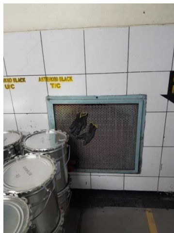
Gambar 4.5 Ventilasi ruang pencampuran dan penyimpanan
