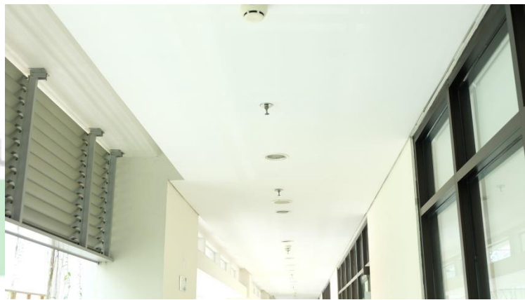
Gambar 4.12 Sprinkler Otomatis
