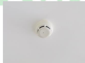
Gambar 2.5 Detektor Asap
