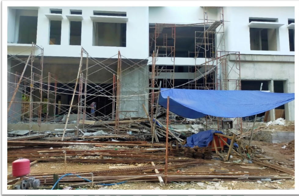
Gambar 4. 22 Bagian depan Proyek Konstruksi PT. Imaji Cipta Tridhistana
