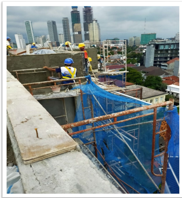
Gambar 4. 23 Proses Pekerjaan Ketinggian
